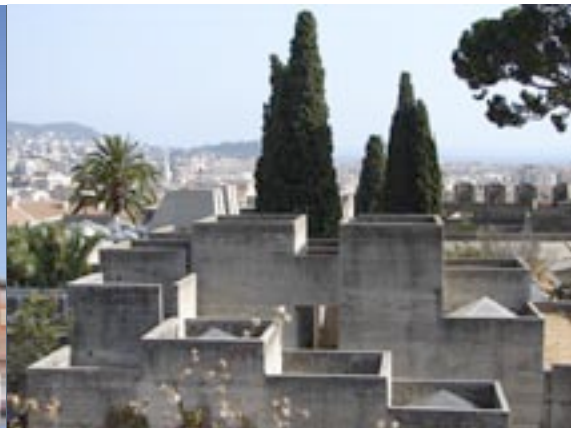
Dakterrassen Villa Arson
